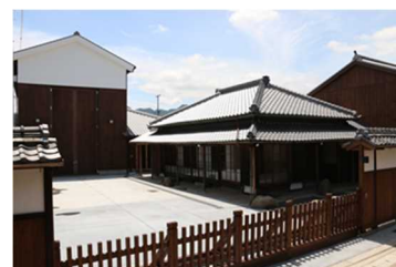
「関の山車」会館整備後
