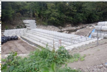
仮設ブロック堰堤 (設置イメージ)
