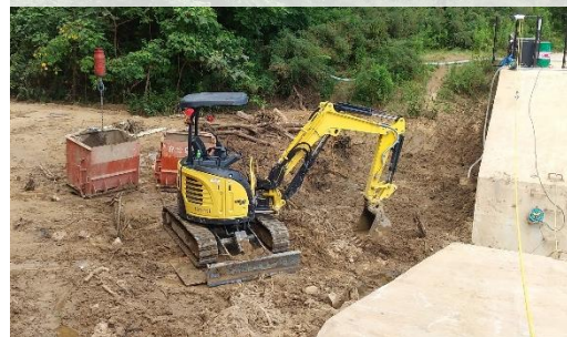
既設砂防堰堤の除石 (施工イメージ)
