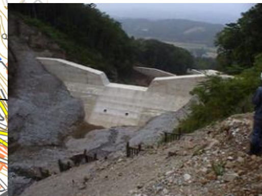
砂防堰堤の新設 (設置イメージ)
