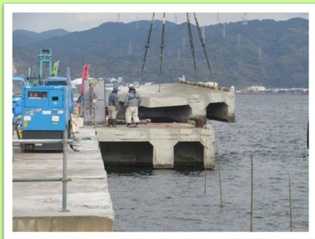
既設岸壁の撤去状況
