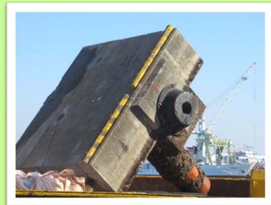
撤去した既設岸壁の一部
