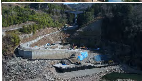
転流工吐口部施工状況
