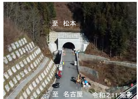
令和3年秋頃開通に向けた 工事の状況 桜沢改良
