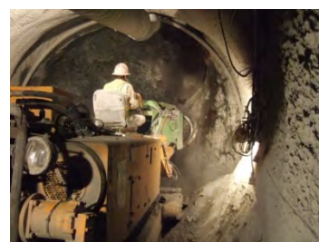
排水トンネル工
