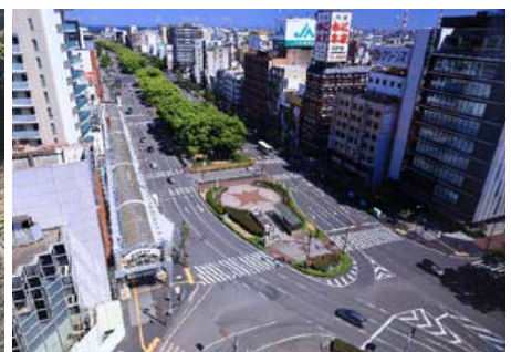
近鉄四日市駅前(中央通り)の状況 国道1号近鉄四日市駅交通ターミナル整備事業 令和3年度新規事業化
