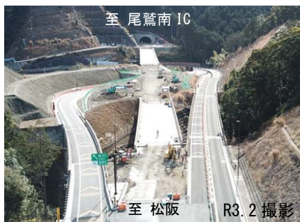
至尾鷲南IC 至松阪 R3.2撮影 令和3年夏頃開通に向け工事が進む 熊野尾鷲道路Ⅱ期 尾鷲北IC付近
