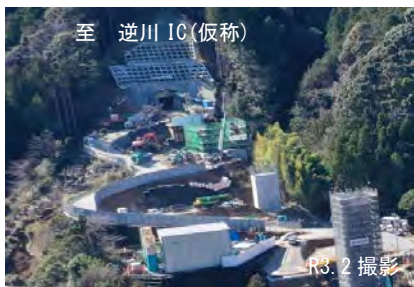
伊豆縦貫自動車道河津下田道路（Ⅱ期） 河津トンネル(仮称)付近
