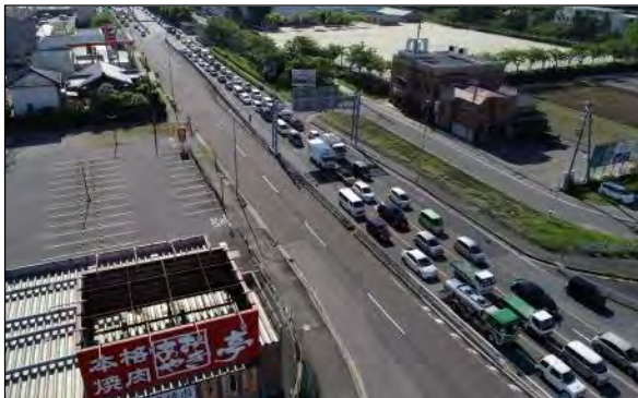
《《 直進車線の増設を予定 》》
