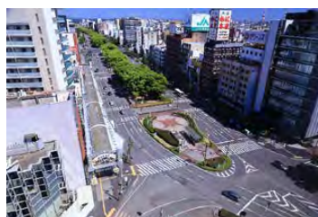
近鉄四日市駅前(中央通り)の状況 (国道1号近鉄四日市駅交通ターミナル整備事業)
