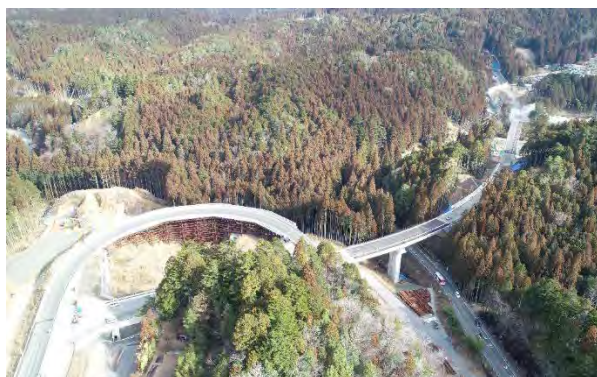
付替県道設楽根羽線(1号橋～1号トンネル)
