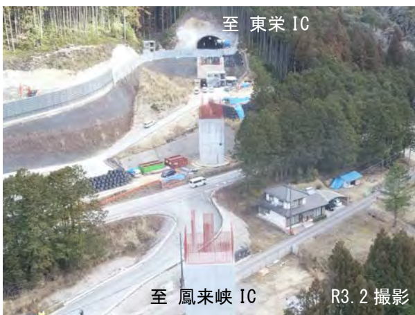
7号橋 橋梁工事の状況 さくま 佐久間道路・ さんえん 三遠道路
