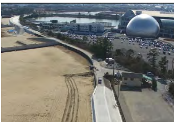
整備前の堤防(阿漕浦・御殿場工区)
