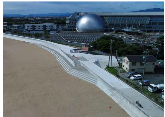
整備後の堤防(阿漕浦・御殿場工区)
