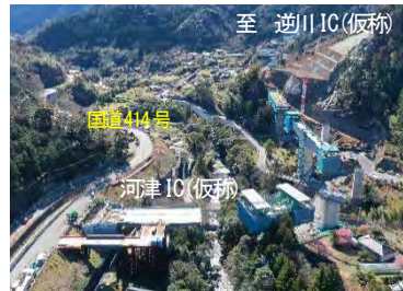
国道 414 号河津下田道路(Ⅱ期) 河津 IC 付近
