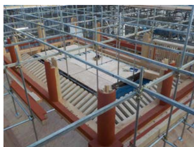
南門の復元整備の状況
