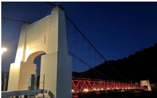
美濃橋 (国指定重要文化財)
