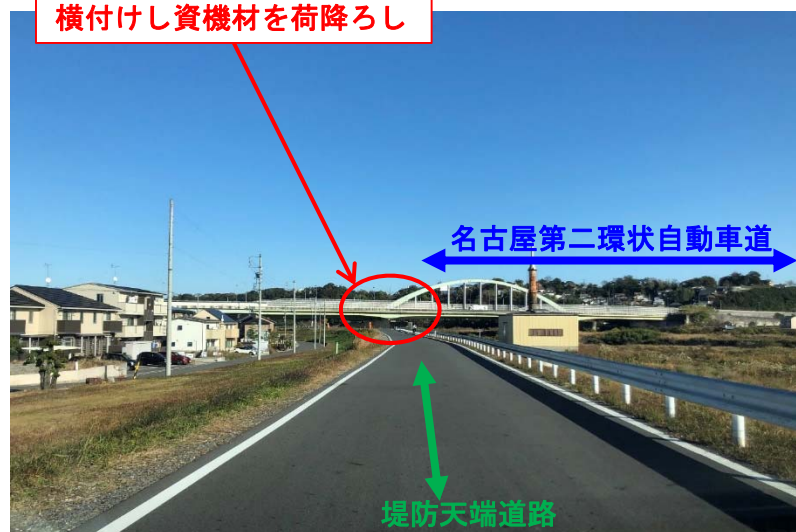
高速道路と堤防天端道路の立体交差部 〔写真上：庄内川左岸19.4k+202m付近〕 〔写真下：庄内川右岸32.4k-86m 付近〕
