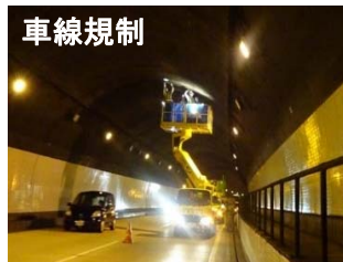
高所作業車による近接目視
