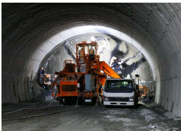
トンネル工事を見学できます！
