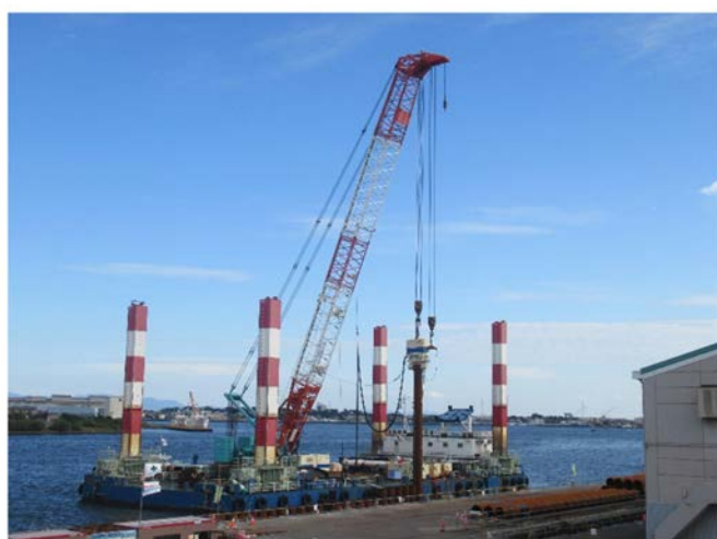
鋼管矢板の打ち込み状況
