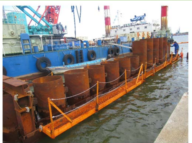
鋼管矢板の打ち込み状況
