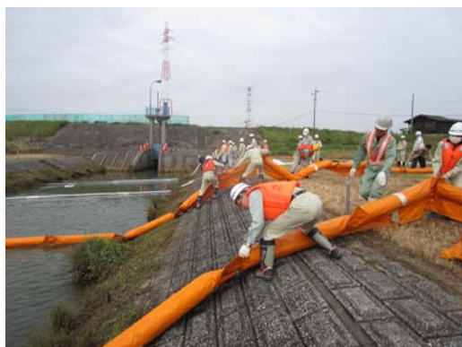
オイルフェンス設置訓練
