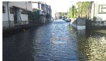
【写真①浸水状況】
