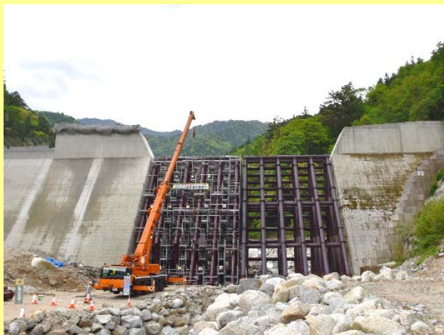
河-1 5 木曾川水系越百川第3砂防堰堤工事
