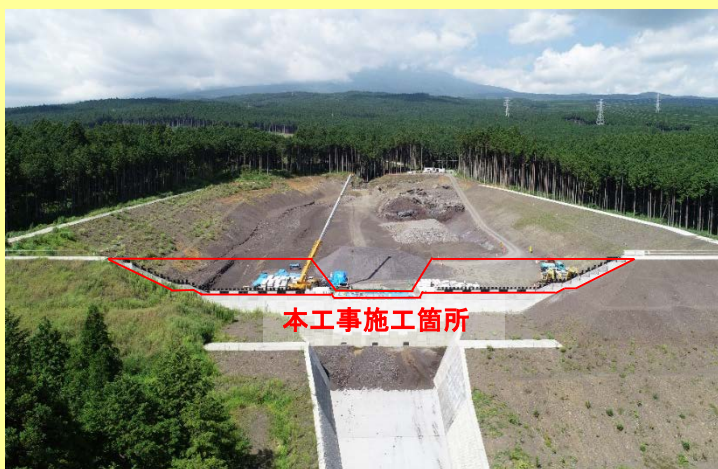
河-2 富士山砂沢上流遊砂地工事
