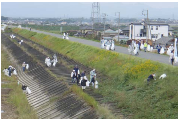
雲出川 三重県津市
