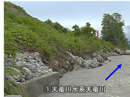
●護岸の損傷
