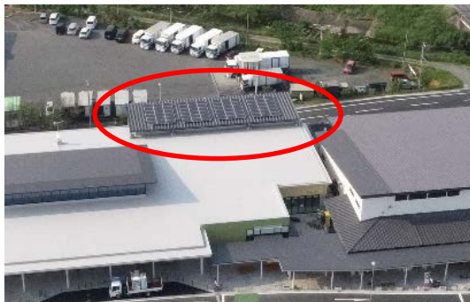
▲太陽光パネルによる非常用電源
