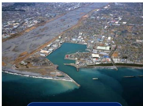
港湾施設(大井川港)
