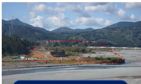
河道の開削工事(牛尾山)
