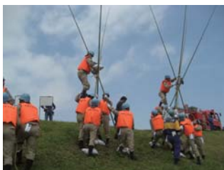
水防工法事例: 籠止め工
