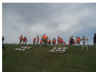
水防工法事例: 屏風返し工
