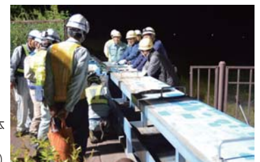
水防団(消防団)、地方自治体 との合同点検事例 (塩田橋陸間: 岐阜県大垣市)
