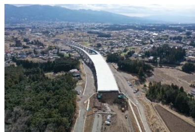
御殿場バイパス (西区間)
