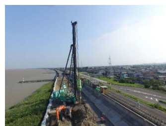
木曾川津波対策耐震事業
