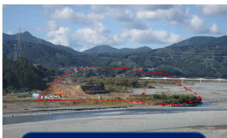
河道の開削工事(牛尾山)
