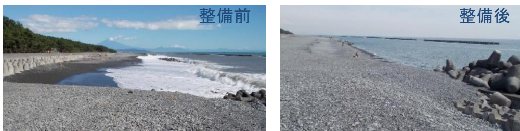
写真 3-9 養浜の実施状況（大井川工区）
