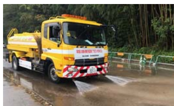
【路面清掃作業】
