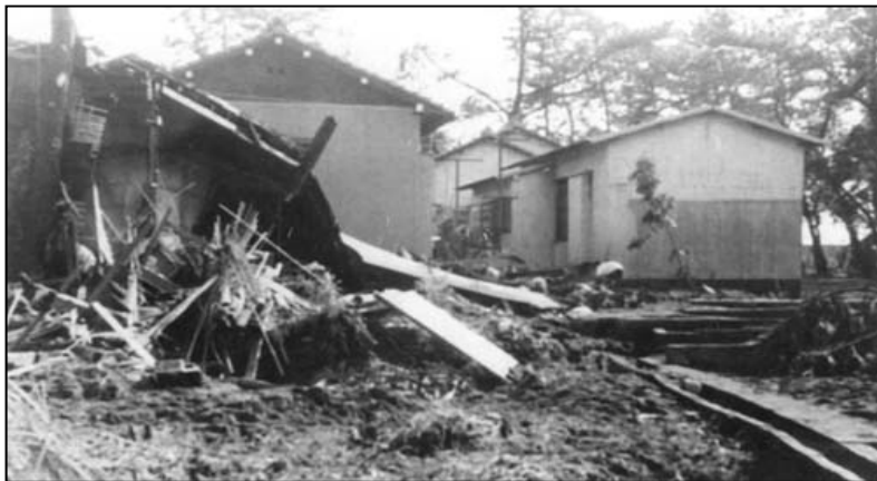
昭和41年9月台風26号 高波・浸水により 被災した家屋(焼津工区田尻地先)
