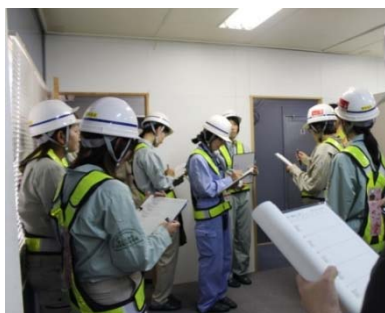
女性技術者が活躍している 現場環境視察実施の様子
