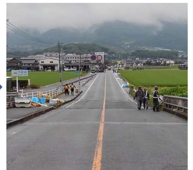
排水作業完了時
