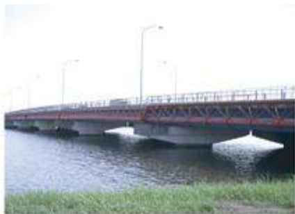
新篠川橋水管橋
