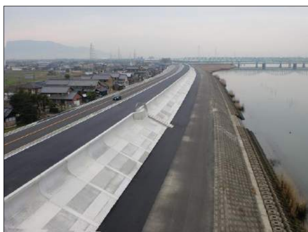
高潮堤防の遠景(平成22年3月撮影)
