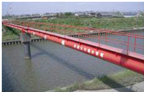
新善太川橋水管橋
