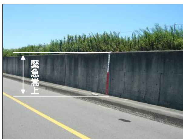
緊急的に嵩上げた波返工(昭和61年度完成) (平成19年撮影)
