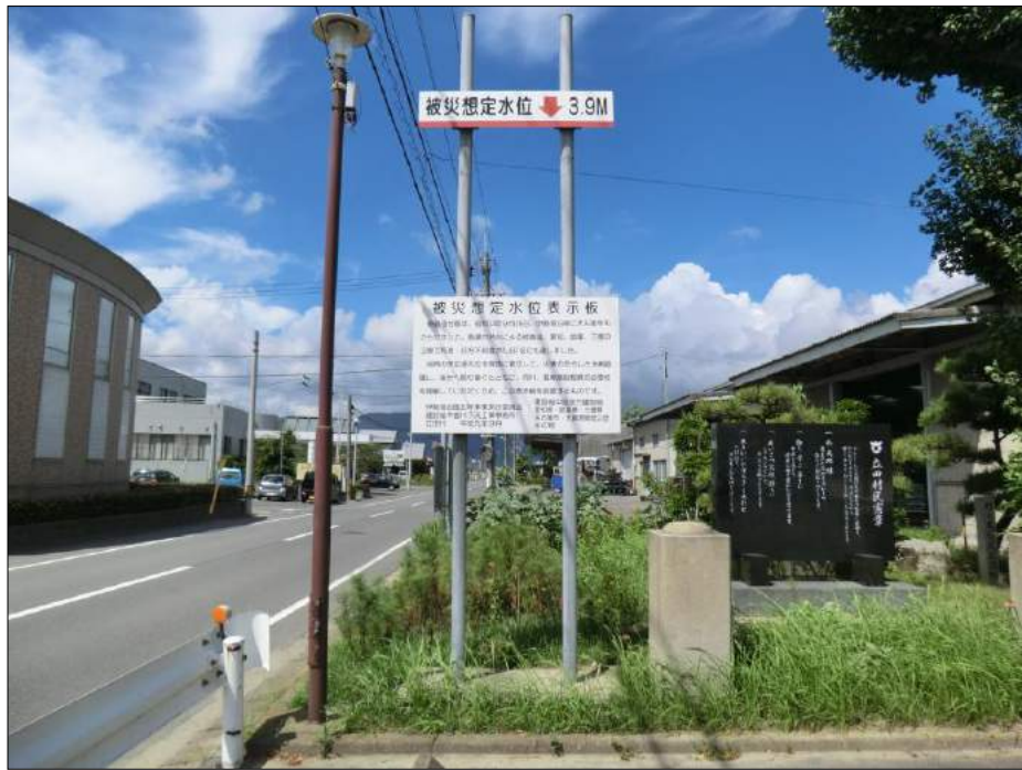
写真-5 愛知県愛西市立田庁舎(旧海部郡立田村役場)における被災想定水位の表示 (平成24年8月撮影)
