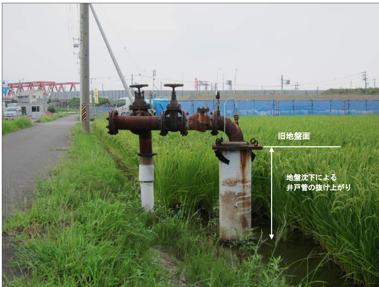
写真-1 三重県桑名郡木曾岬町の井戸の抜け上がり状況（平成29年7月撮影）
