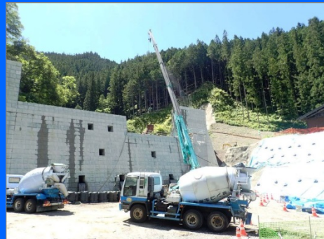
クレーンによるコンクリートの 持ち上げ作業
