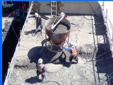
コンクリートバケットによる 打設状況
