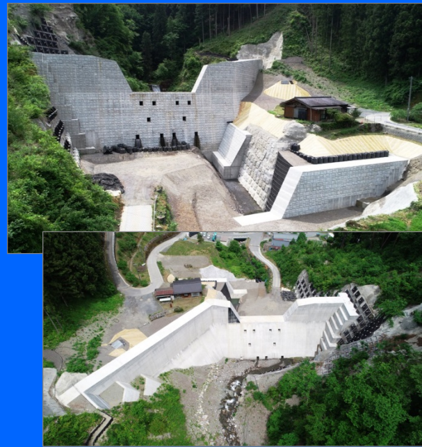
現在施工中の砂防堰堤
