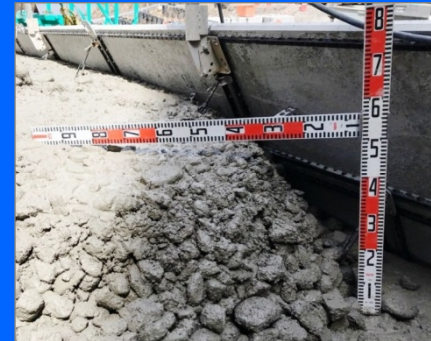
最大粒径80mmの骨材を 使用したコンクリート
