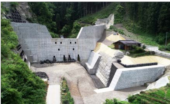
河-30 天竜川水系 ツベタ沢砂防堰堤工事
