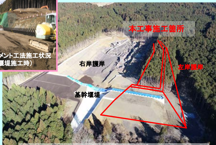
遊砂地下流から上流を望む(平成31年1月現在)
