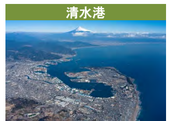
写真提供:国土交通省清水港湾事務所
