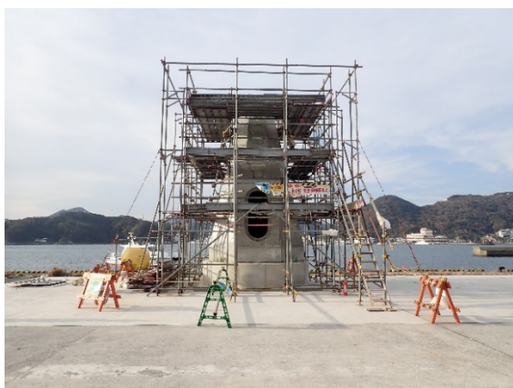
<灯台製作状況>
