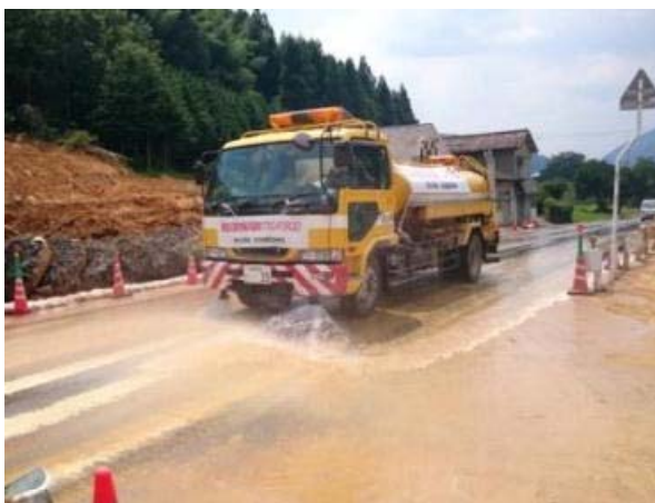
道路の清掃作業
