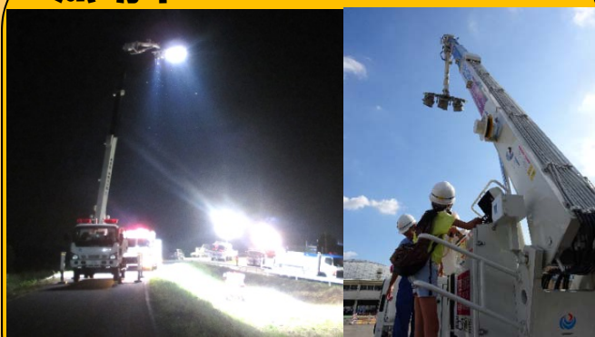
H27関東・東北豪雨での照明作業
