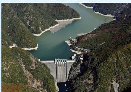
水力発電(佐久間ダム)
