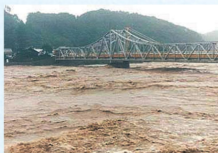
洪水被害の状況(昭和57年,浜松市鹿島地区)
