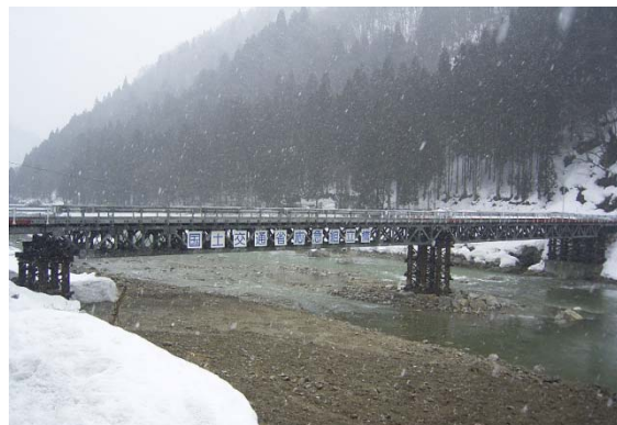
平成16年 台風23号災害 岐阜県飛騨市宮川町内国道360号での架設状況
