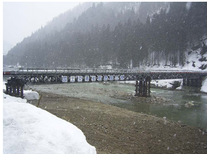
H16 台風23号災害 岐阜県飛騨市宮川町内国道360号で架設された応急組立橋
