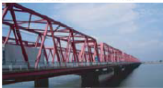
■木曾川大橋 橋長858m 1963年架設
