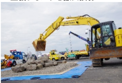
<県建設業協会等によるがれき撤去>
