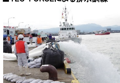
<排水ポンプ車を使用した排水活動>
