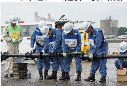
<宮崎管工事共同組合等による復旧訓練>
