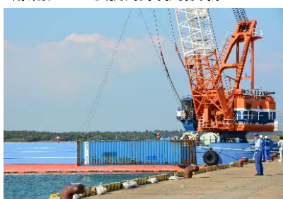
<災害協定団体の起重機船啓開>
