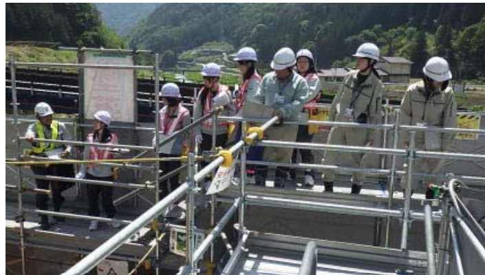
《パト状況(他工事)》
