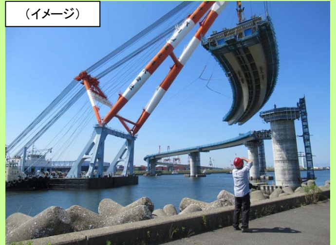
大型クレーンによる海上架設状況
