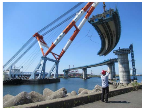
港-2：四日市港 臨港道路(霞4号幹線)の整備
