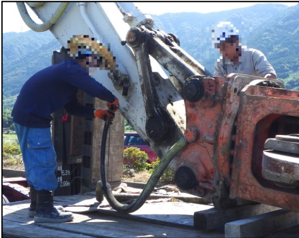
分解作業状況
