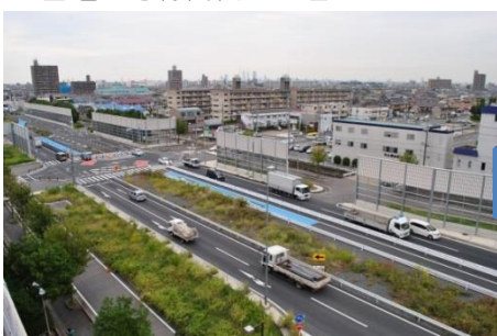
C 東海通北側から名古屋西JCTを望む
