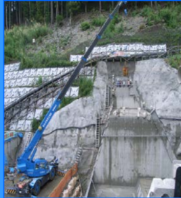
〈コンクリート打設の様子〉
