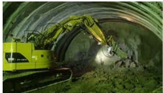
道-6：伊豆縦貫自動車道(天城北道路) 矢熊地区
