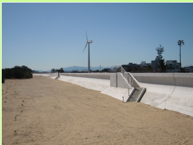
完成した堤防（津地区栗真町屋工区）
