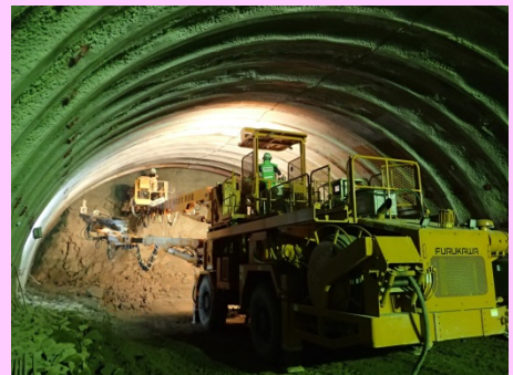
ロックボルト施工状況
