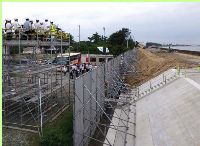
堤体製作（本体工）（平成29年9～11月頃予定）
