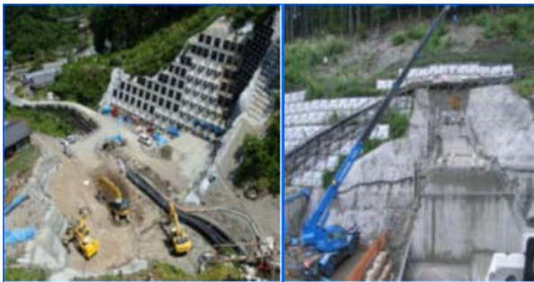
河-20：ツバタ沢砂防堰堤工事
