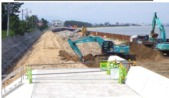
港-1：津松阪港 海岸保全施設の整備
