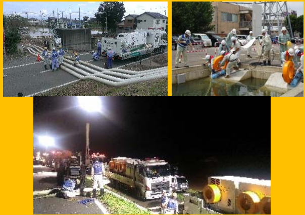
H27関東・東北豪雨での排水作業
