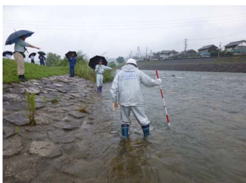
土岐川左岸57.2kp付近
