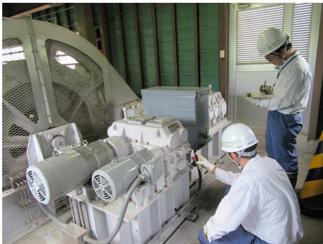
牧尾ダムにおける余水吐ゲートの点検状況
