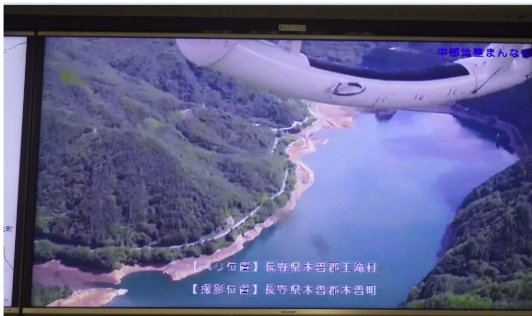
「まんなか号」による点検状況（牧尾ダム上空）
