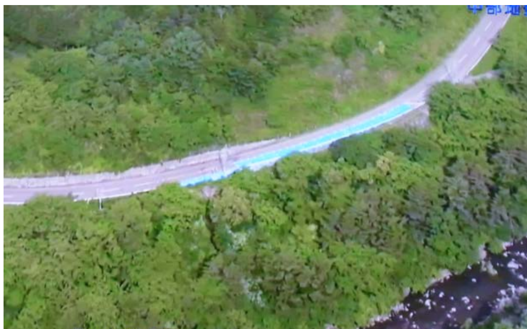
「まんなか号」による点検状況
