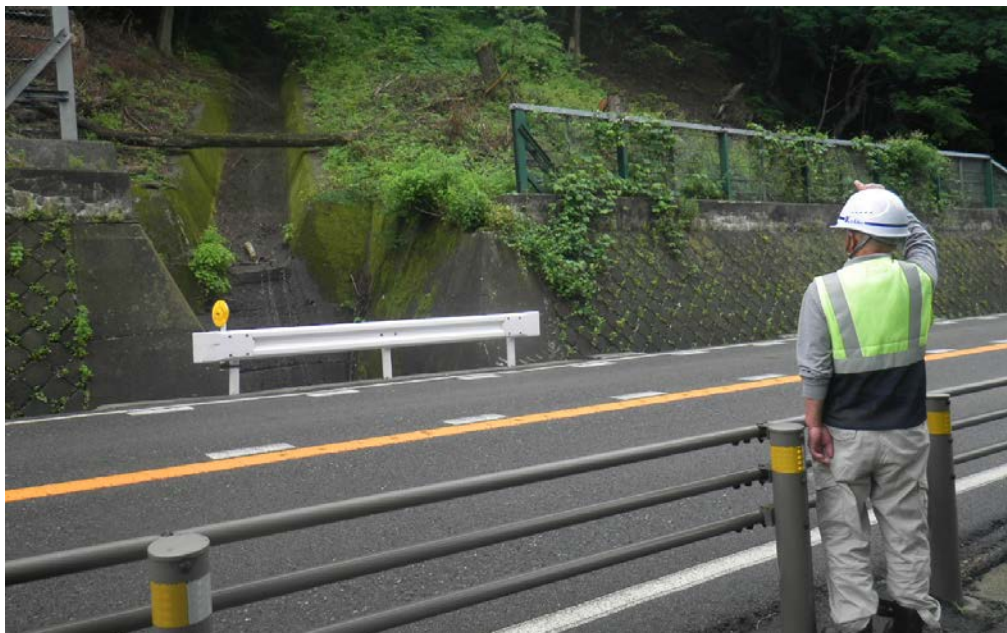
道路（国道19号）法面点検状況
