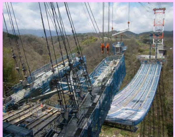
※上部工の架設施工中
