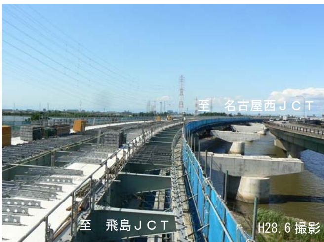
橋梁工事が進む とびしま 飛島大橋
