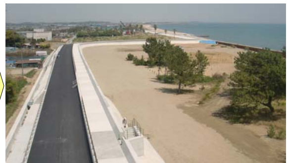
整備後の堤防(栗真町屋2工区)
