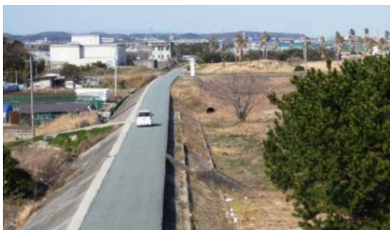
整備前の堤防(栗真町屋2工区)
