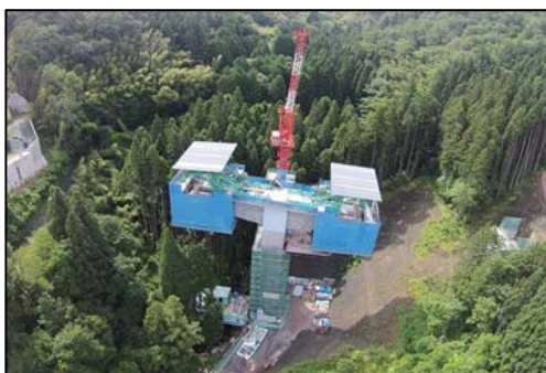
付替県道井尻八百津線（橋梁工事）
