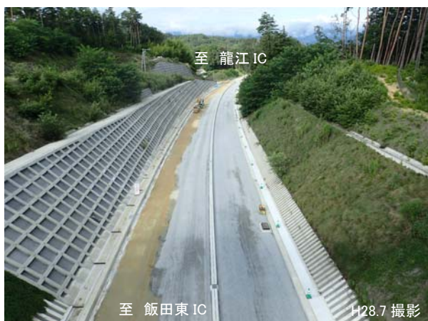
H29年度開通に向け舗装工事が進む 飯橋道路 下久堅地区付近
