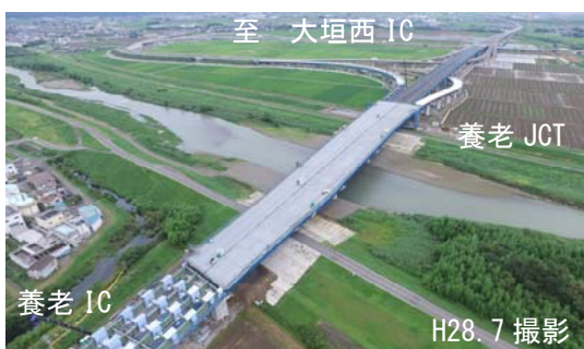
H29年度開通に向け橋梁工事が進む 養老JCT付近
