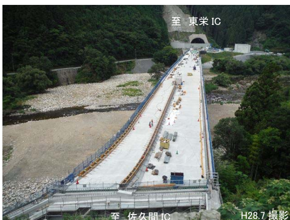
H30年度開通に向け橋梁工事が進む 三遠道路・佐久間道路 大千瀬川橋
