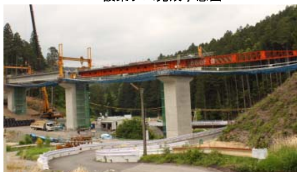
付替県道設楽根羽線の施工状況
