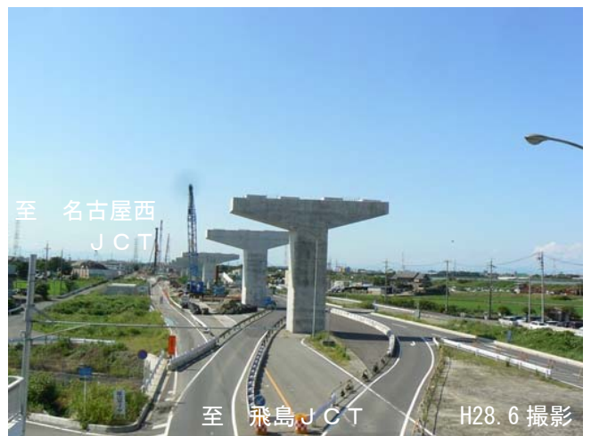
橋梁工事が進む うめのごう 梅之郷交差点付近
