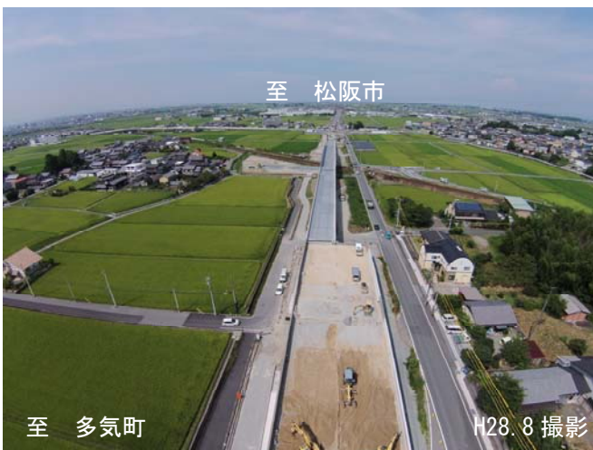
H28年度開通に向け橋梁工事が進む 上川町付近
