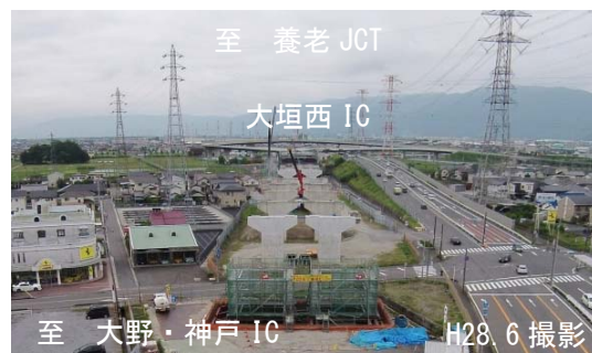
H31年度開通に向け橋梁工事が進む 福田町付近
