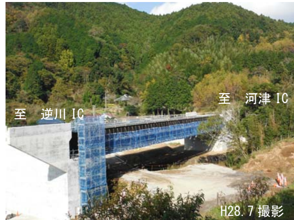
橋梁工事が進む 河津下田道路(Ⅱ期) 2号橋
