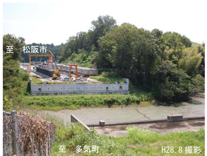
H29年度開通に向け橋梁工事が進む 下蛸路町付近
