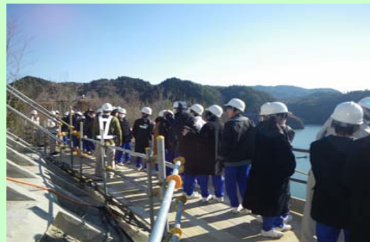
斜面にあるアンカー工の現場で間近に説明を聞く
