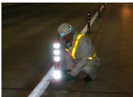
車線分離標更新作業
