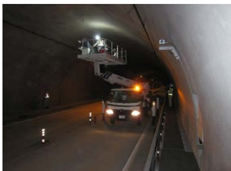
トンネル点検作業
