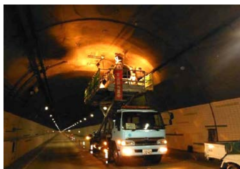
トンネル内ジェットファン撤去
