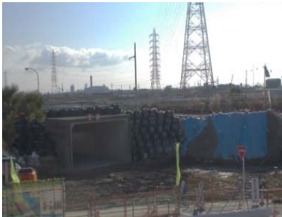
横断ボックス延伸工事現場状況
