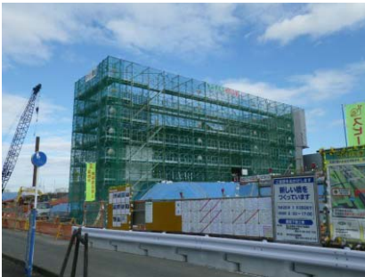
下部工事現場状況
