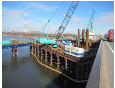
日光川河川内の下部工事現場状況
