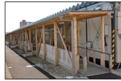
仙台市 仮設住宅のバリアフリー化
