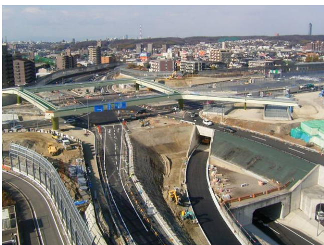
国道302号の建設状況（植田IC付近）
