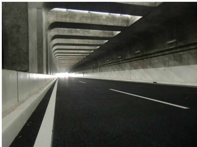
高針JCT～植田IC間[掘割部]
