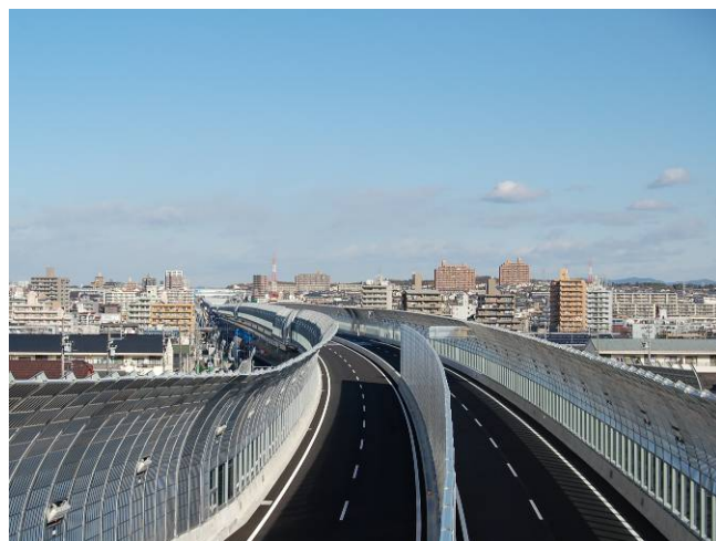
植田IC～鳴海IC間[橋梁部]
