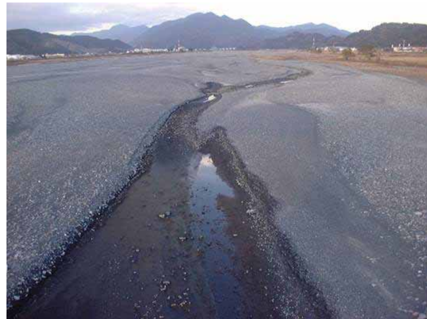
安倍川 瀬切れ状況写真
